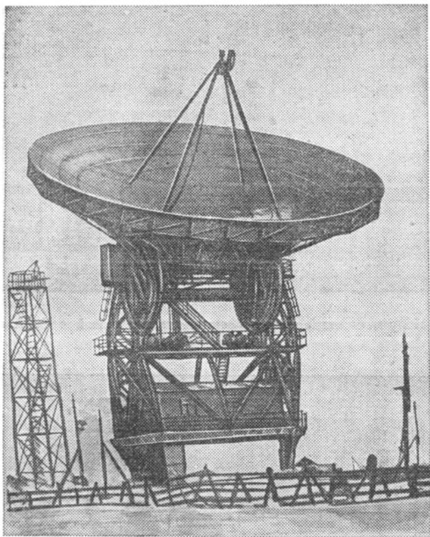
Рис. 54. Серпуховский радиотелескоп Физического института Академии наук СССР (диаметр зеркала 22 м).
